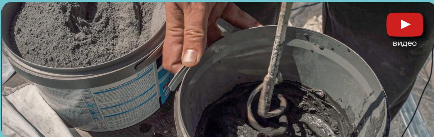
Заполните швы, используя наполнитель в пластиковом пакете или пистолете для герметика. Консистенция должна напоминать пластилин.
