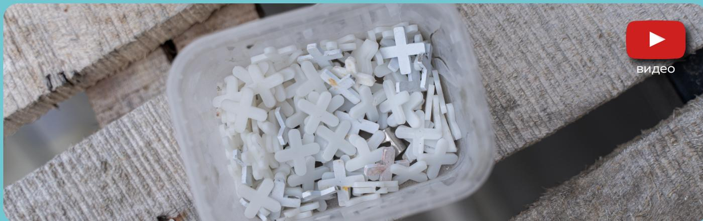
Дистанциры сохраняют ширину швов между плитами по вертикали и горизонтали до полного сцепления их со стеной. Это позволит выполнить монтаж аккуратно и подготовиться к следующему этапу - затирки.
