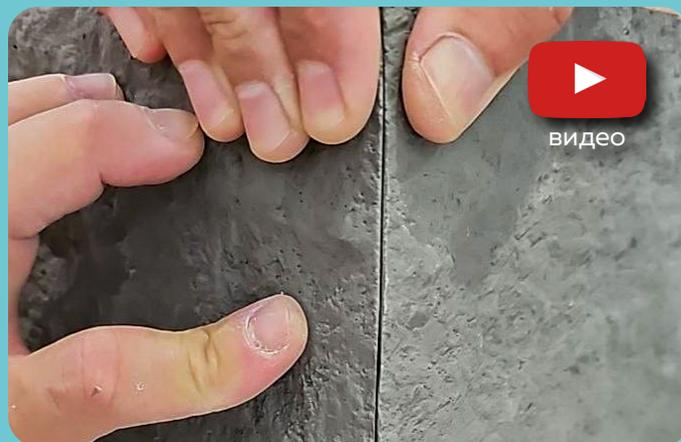
Аккуратно состыкуйте кромки друг с другом и отрегулируйте положение плит, хорошо прижмите к поверхности, обеспечивая сцепление плит со стеной.
