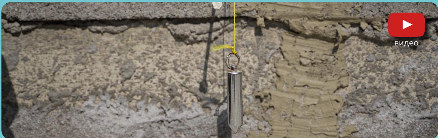
Отмеряем от стены по 6 см, закрепляем расстояния узлами для последующего монтажа минваты.
